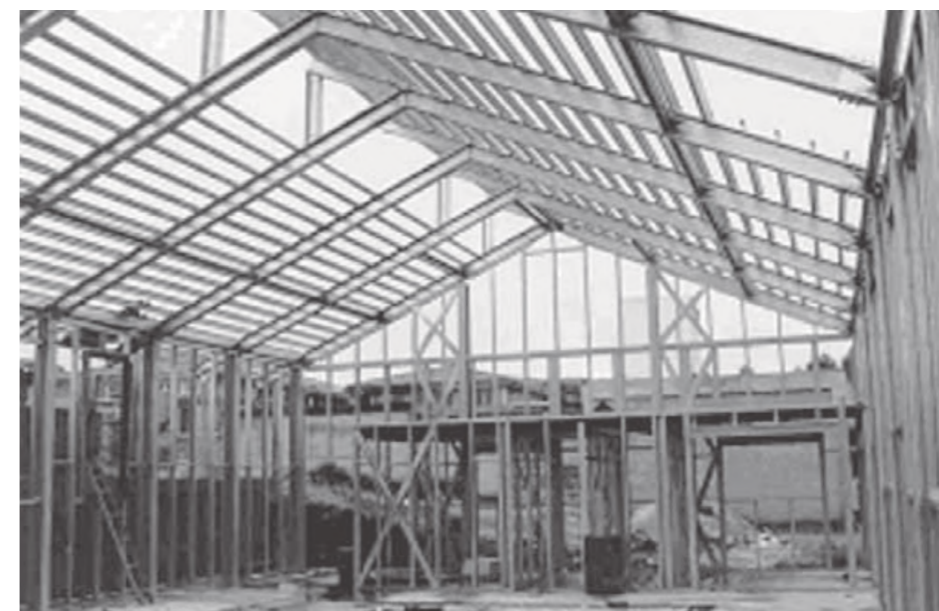
Foto 5.2 - Telhado estruturado com caibros em um laboratório na Universidade Federal de Ouro Preto - MG (Fonte: Arquivo Célso Firmo)
