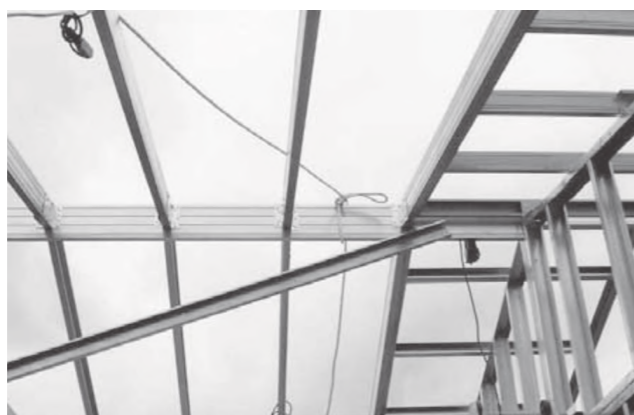
Foto 5.3 - Cumeeira composta de perfis U e Ue para apoio dos caibros
