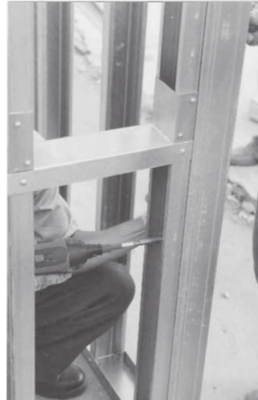
Foto 3.6 - Bloqueador e fita de aço galvanizado fixados ao painel para travamento horizontal
