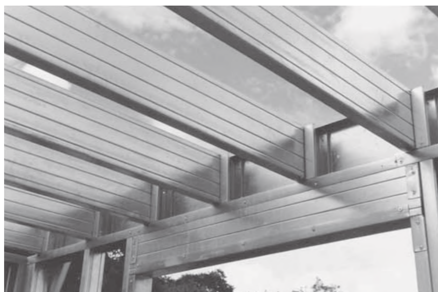
Foto 4.1 - Vigas de piso
