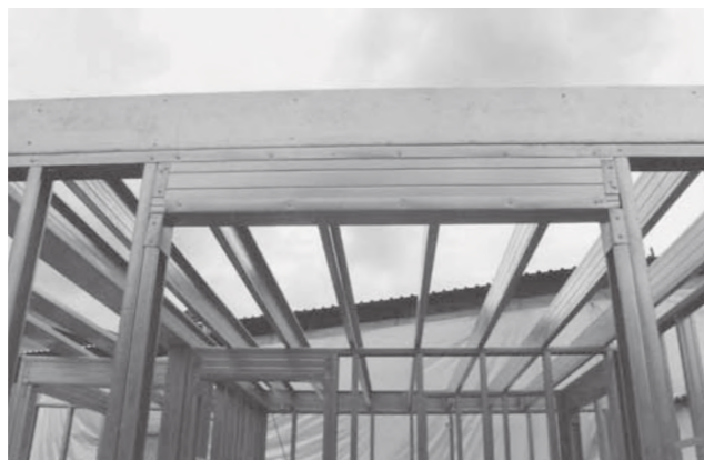
Foto 4.5 - Vigas de piso apoiadas em montantes de painéis do pavimento térreo
