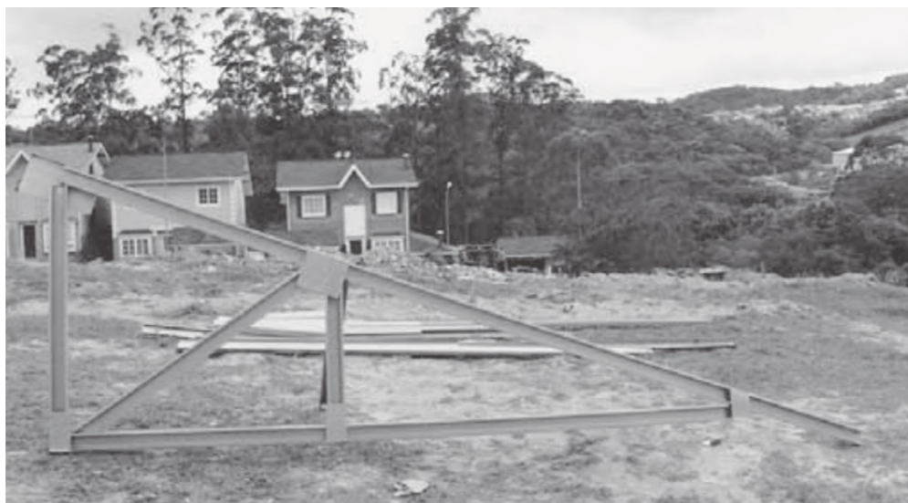
Foto 5.4 - Tesoura em "meia-água", cujos elementos estão fixados em placas metálicas de aço (placas de Gusset)
