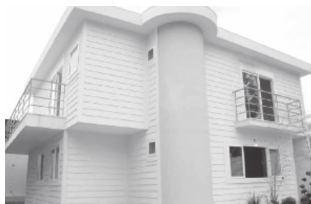
Foto 2.5 - Residência em São Paulo – SP (Wall Tech)
