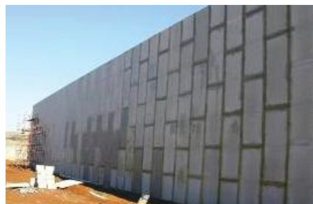
Juntas invisíveis em fachadas com tratamento de resina de poliéster.
