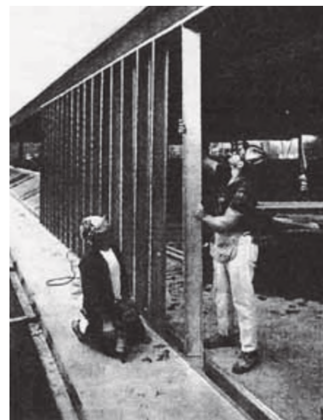
Foto 2.9 - Light Steel Framing montado pelo método “stick” (Fonte: Robert Scharff)
