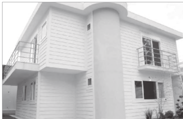
Foto 3.7 - Residência em São Paulo - SP (Wall Tech)
