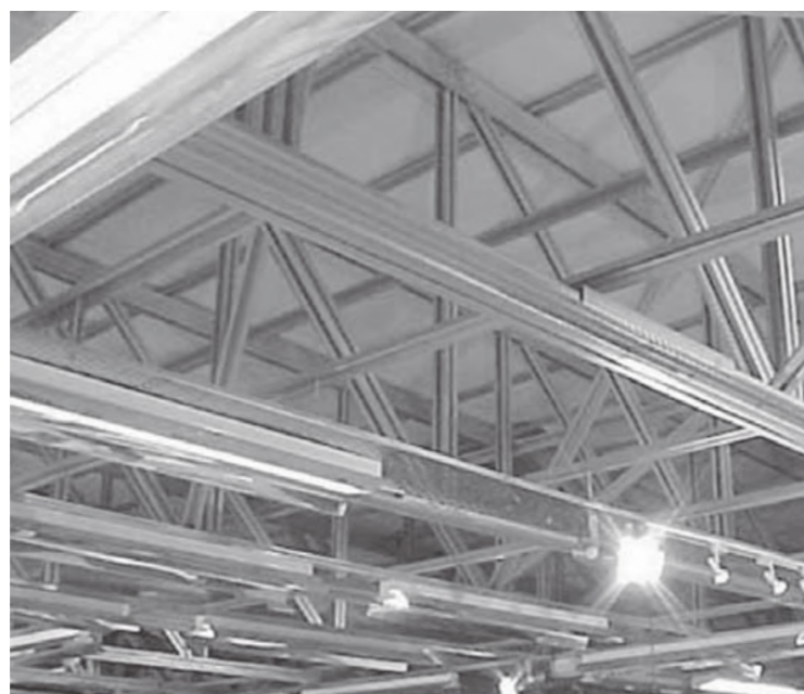
Foto 5.1 - Treliças planas (Fonte: http://www.aegismetalframing.com )
