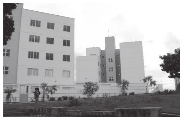
Foto 2.8 - Edifício de 5 pavimentos em Belo Horizonte – MG (EPO)
