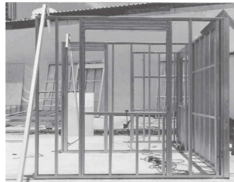
Foto 3.1 - Painel com abertura de janela
