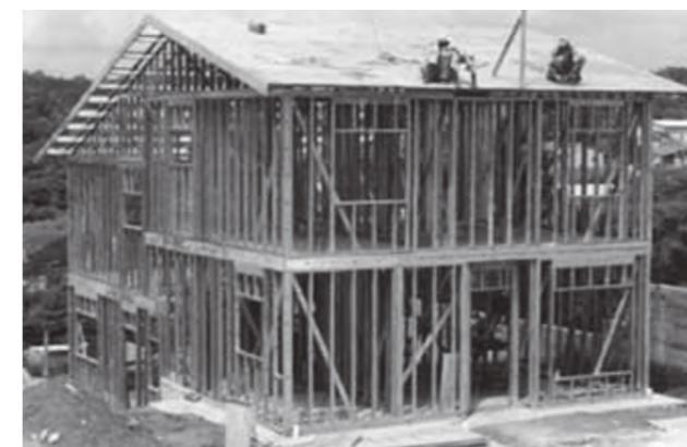
Foto 2.1 - Estrutura de residência em Light Steel Framing, São Paulo (Fonte: Construtora Sequência)
