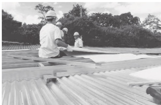
Foto 4.2 - Forma de aço para contrapiso úmido
