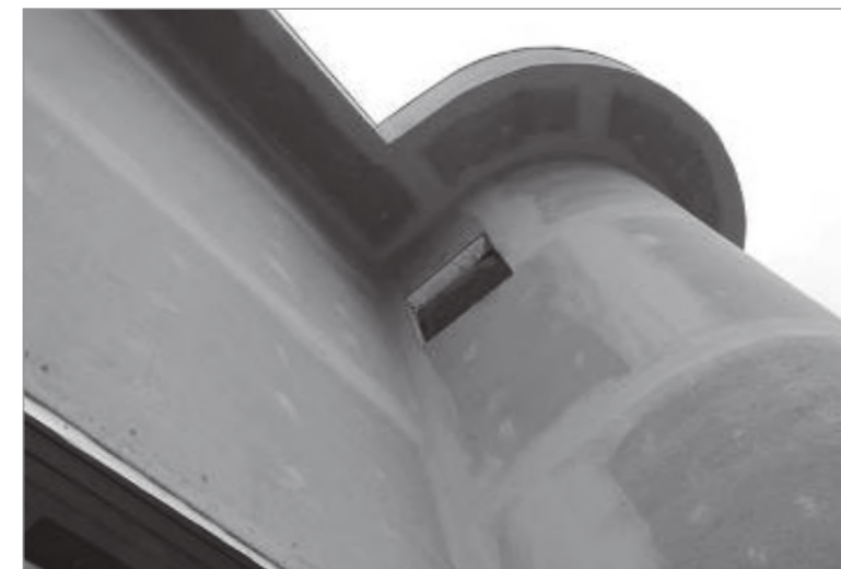
Foto 6.1 - Fechamento vertical com Placas Cimentícias Impermeabilizadas Brasilit 10 mm (Fonte: Wall Tech)
