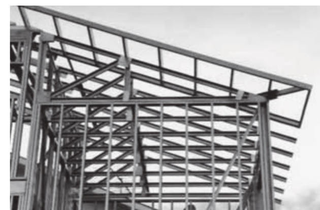
Foto 2.4 - Estrutura do telhado de residência em Light Steel Framing
