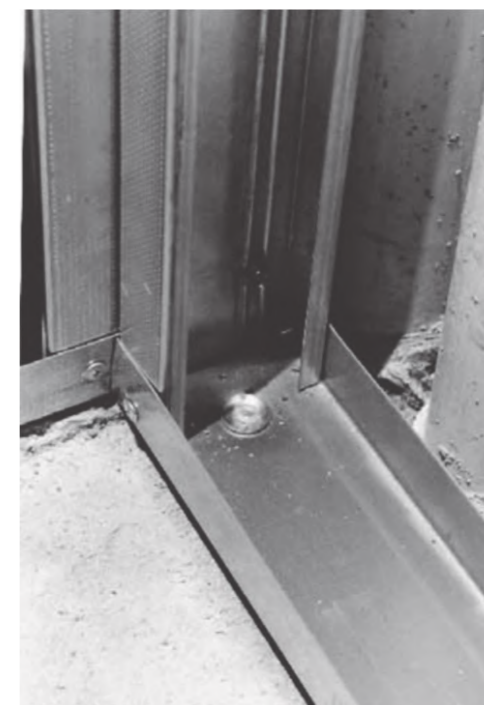
Foto 2.14 - Ancoragem provisória
