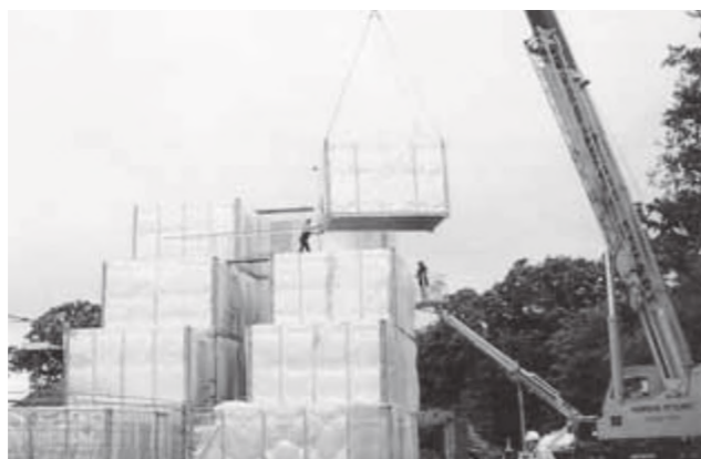
Foto 2.11 - Unidades modulares empilhadas na forma da construção final. O vazio que se vê ao centro formará a circulação de acesso às unidades (Fonte: SCI).
