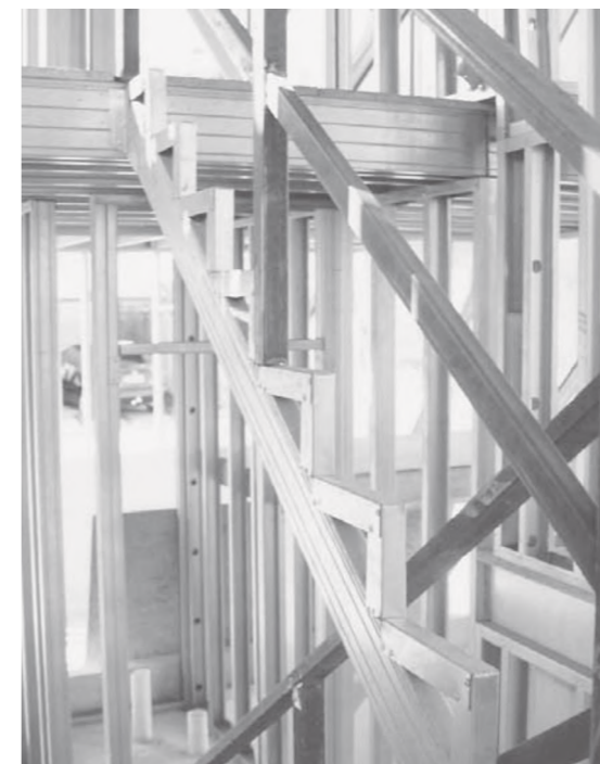
Foto 4.8 - Escada viga caixa inclinada
