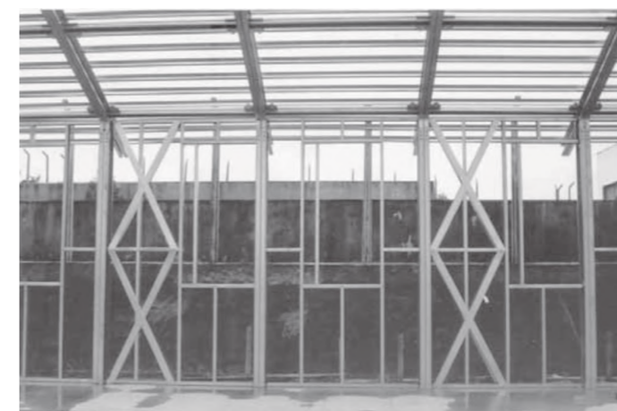
Foto 3.4 - Painéis contraventados em função das aberturas em laboratório na Universidade Federal de Ouro Preto
