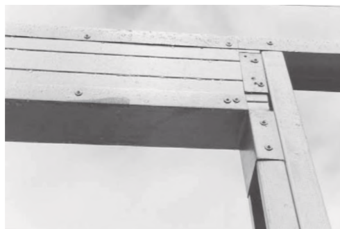
Foto 3.2 - Detalhe de verga para abertura de janela
