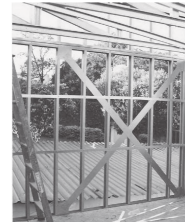
Foto 3.3 - Painel com contraventamento em "X"
